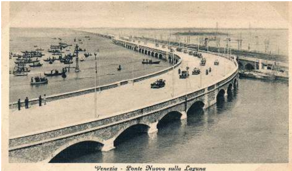
Venezia - Ponte Nuovo sulla Laguna Fig 1: Ponte della Liberta
